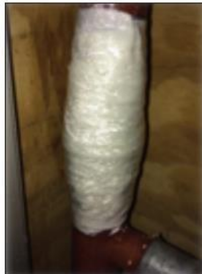
Foto 12 en 13 - Perforeren compressie folie en lekreparatie uitgevoerd
