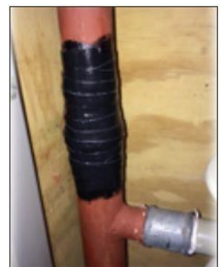
Foto 7 - Leiding met densoleenband aangebracht
