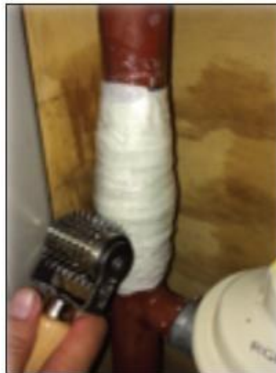
Foto 12 en 13 - Perforeren compressie folie en lekreparatie uitgevoerd
