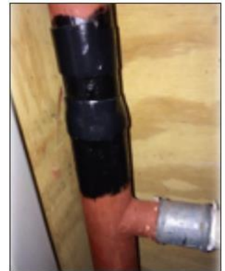
Foto 6 - Leiding met primer aangebracht
