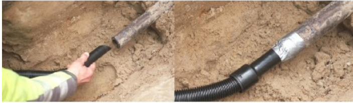
Foto 3 en 4: Een persoon verbindt (links) en aansluit (rechts) asbeststofzuiger op de aansluitleiding
