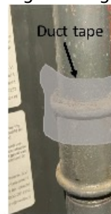
Foto 5 – Aanbrengen duct tape verbinding
