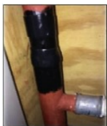
Foto 6 - Leiding met primer aangebracht
