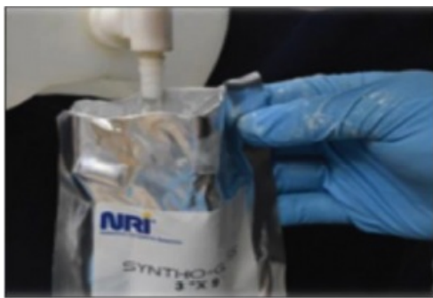
Foto 8 en 9 – Vullen en weken van syntho-Glass band
