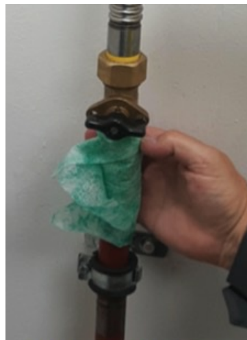
Foto 2 - Reinigen van buis/koppeling
