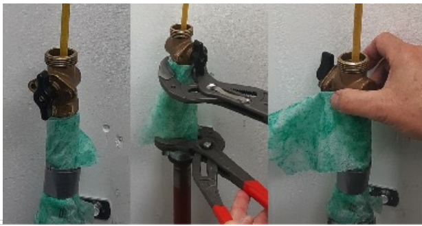
Foto 3, 4 en 5 - Plaatsing doekjes en losdraaien
