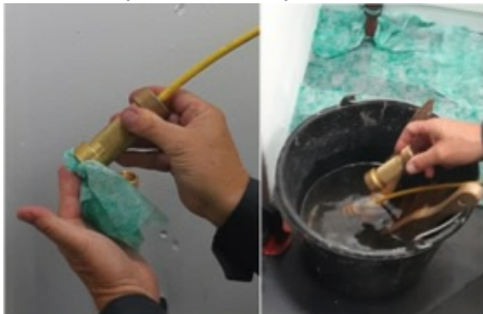
Foto 7 en 8 - Tijdelijke afdichting
